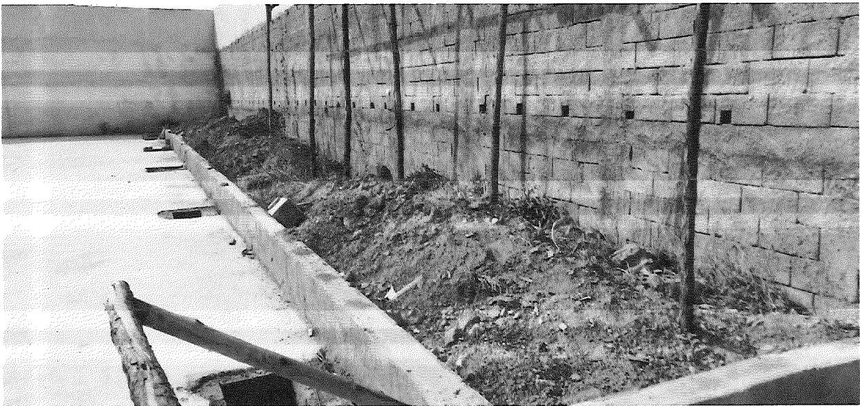
Foto 09: Local da Arquibancada.
