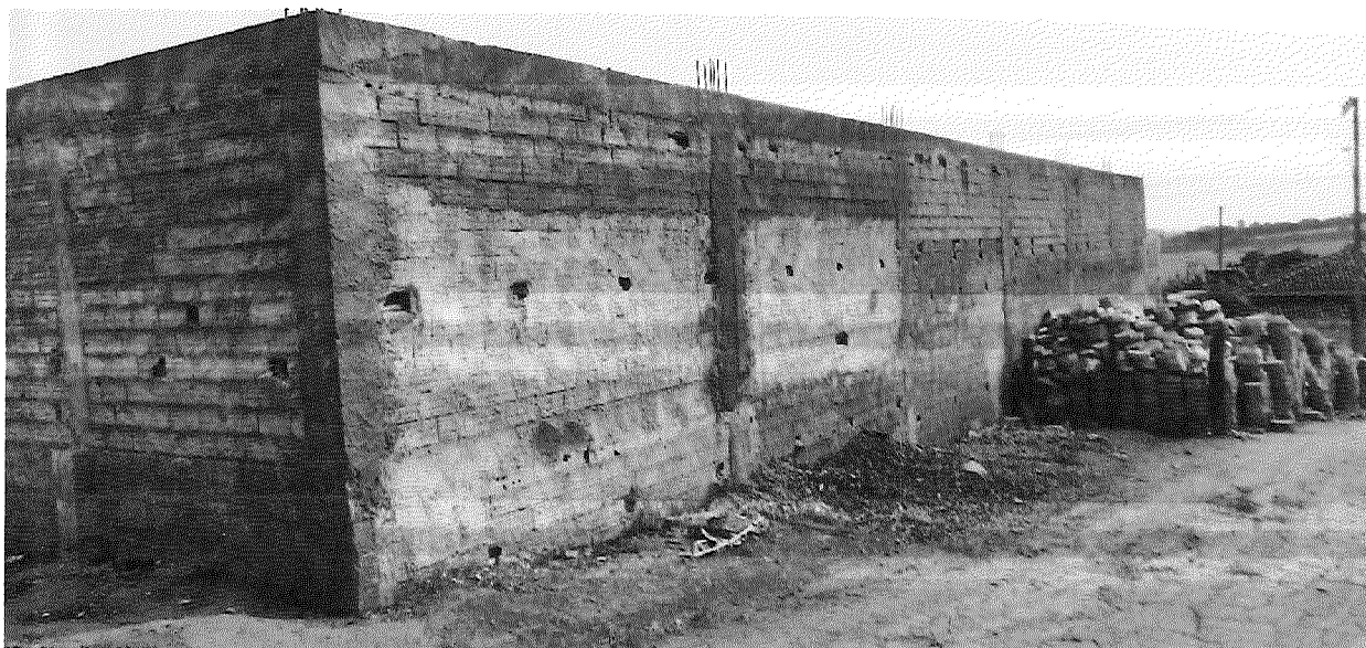
Foto 03: lateral esquerda da Quadra da Boa Vista.
