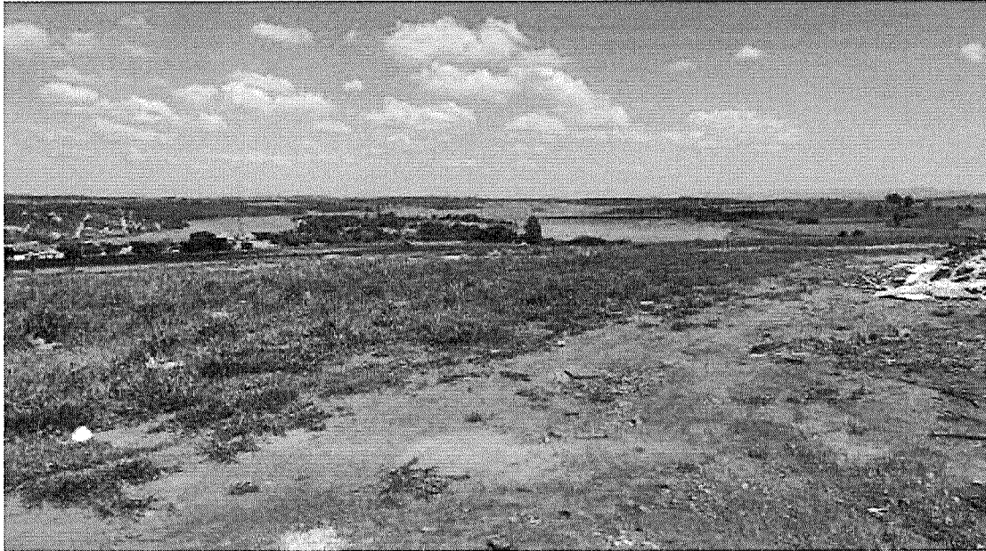
Foto 03: Terreno da construção do Estacionamento
